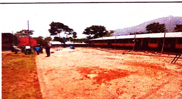
Foto 3: Se observa la instalación de las columnas.
