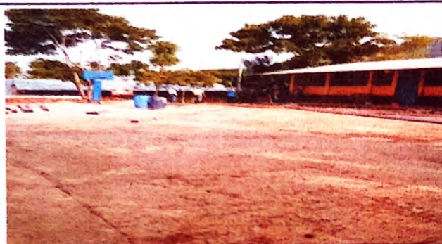
Foto 1: Se observa que en el area se inicio a trabajar.
