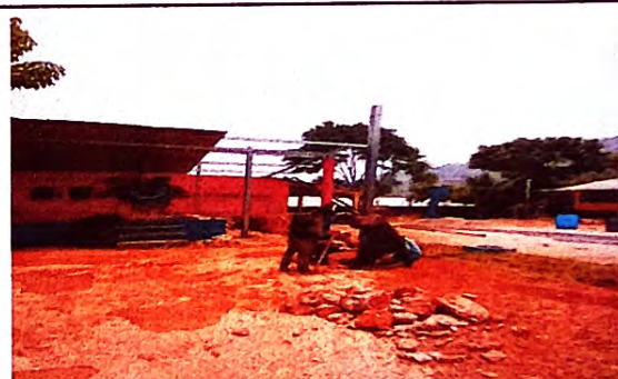
Foto 4: Se observa la instalación de las columnas.
