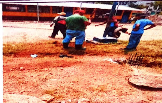
Foto 2: Se Observa el inicio de la excavacion de las columnas.
